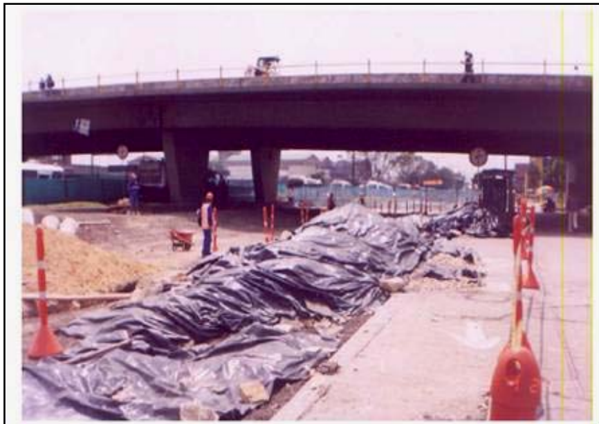
Figura 8.7 Cubrimiento de escombros con plástico
