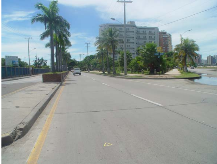
Aspecto general de la Av. San Martin donde deberá movilizarse la maquinaria.
