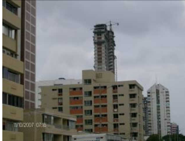
Figura 2.15 Construcción de edificios en Bocagrande en el 2007.
