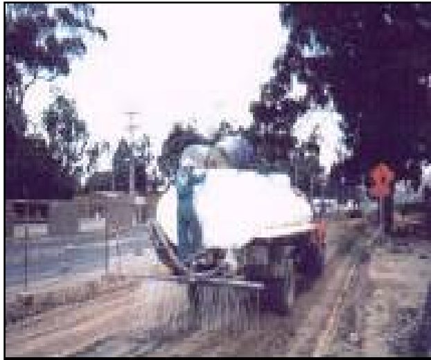
Figura 8.27 Humectación de zonas desprovistas de acabados
