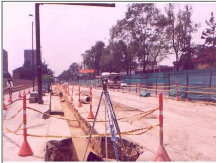
Figura 8.23 Aislamiento de excavación (Adecuación de la Troncal NQS de Transmilenio en Bogotá)
